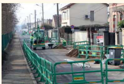
Réfection complète de l'avenue Jacques Potel : 2,50 M€
