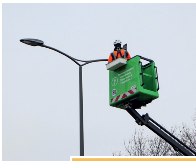
Passage en LED du réseau d'éclairage public : 2 e tranche - 1.06 M €
