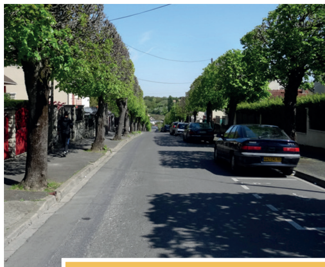
Réaménagement de l'avenue Paul Vaillant Coururier (avant la connexion vers le futur échangeur de la Francilienne) - 1,50 M €
